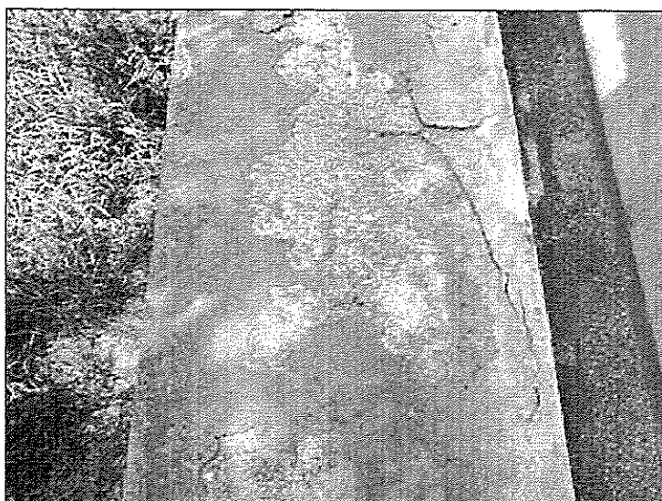
Poruchy sanace říms
